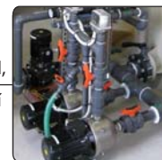
kontrola čerpadiel, ventilov a potrubí
