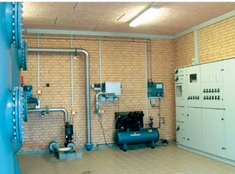
Kompletné riešenie úpravy vody obsahujúce tlakový filter a technologické zariadenie na oxidáciu a preplach.
